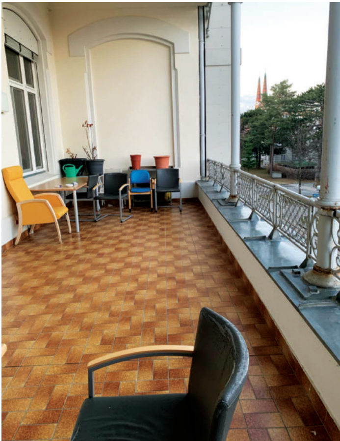
Der Balkon vor Projektbeginn. (Quelle: Christina Bauernfeind)
